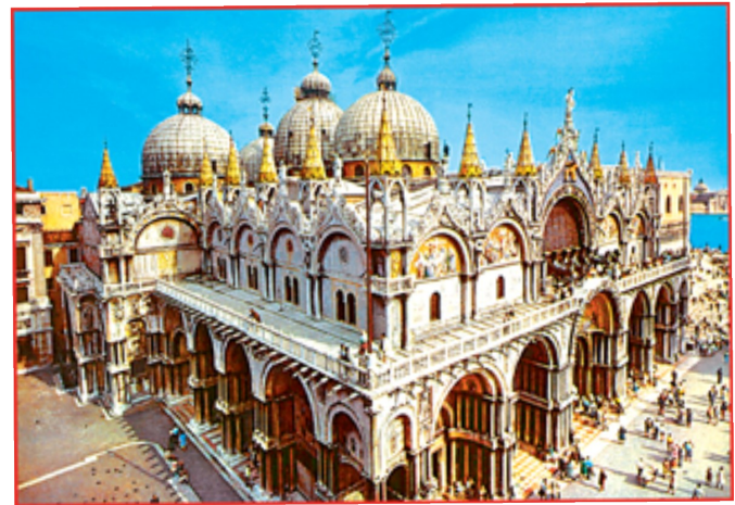
Basilica di San Marco oggi
